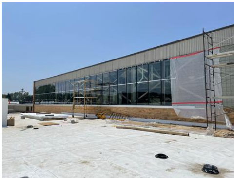
Hawley Gymnasium Windows
