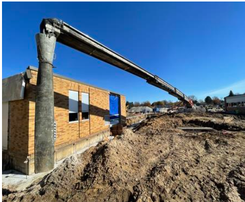
Pouring Column Pads
