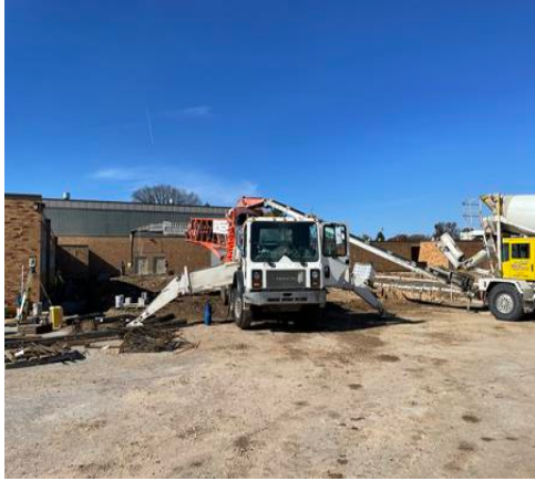
Pouring Column Pads
